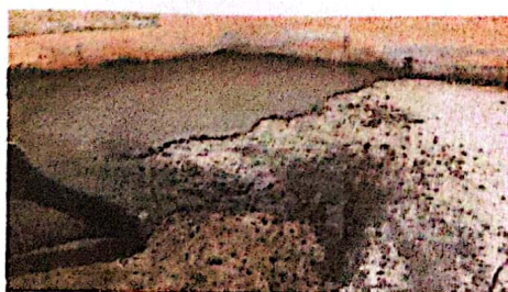
Foto 5: Sustitución de piso
