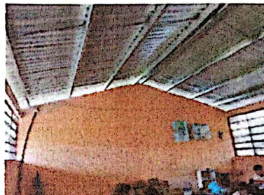
Foto 2: Sustitución de lamina por lamina troquelada
